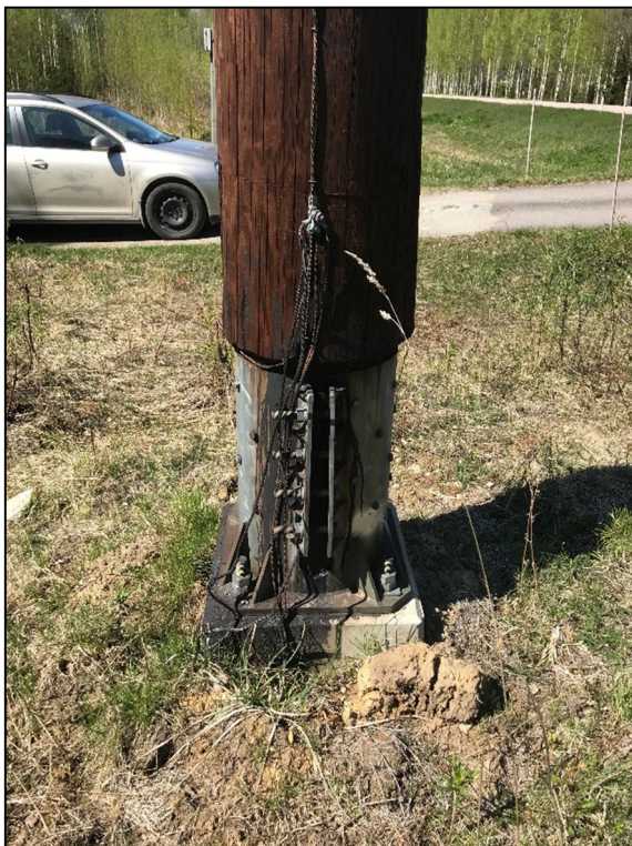
Kuva 08. Pylväs nro. 44. Kyllästettä oli valunut jalustalta maaperään asti. Osa tummasta valumasta jalustalla on aikaisempaa kuivunutta kyllästettä.
