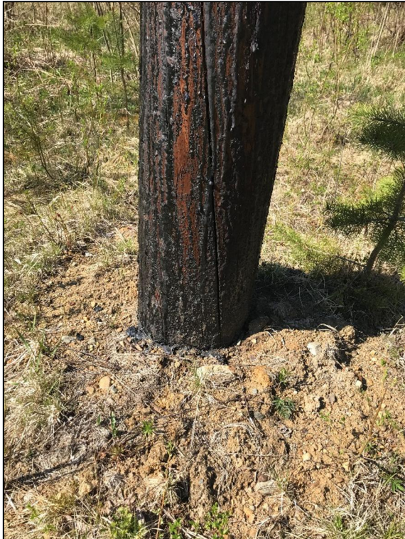
Kuva 06. Pylväs nro. 35. Maaperään asti oli valunut kyllästettä.
